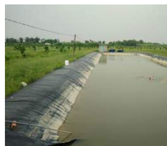
c. Bể nước dùng để cấp nước cho hệ thống tưới
